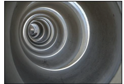
Rioolbuizen voor aanleg HOV-lijn Nuenen.
